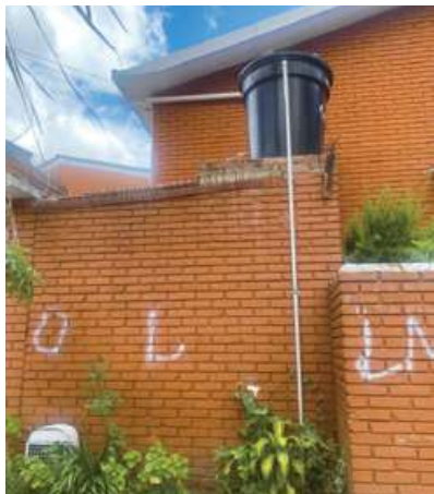
Figura 5. Sistema de captación de agua lluvia en un predio residencial en el ecobarrio la Esmeralda.
